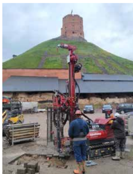
Gręžimas koloniniu būdu (Vilnius, Arsenalo g., 2022 m. spalio). Iš UAB „Geotestus“ archyvo
